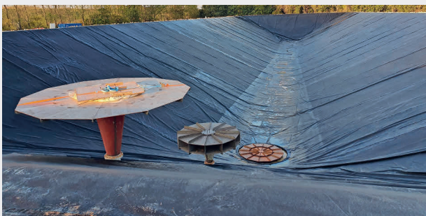
Erdbeckenspeicher in Dänemark, S. 52
