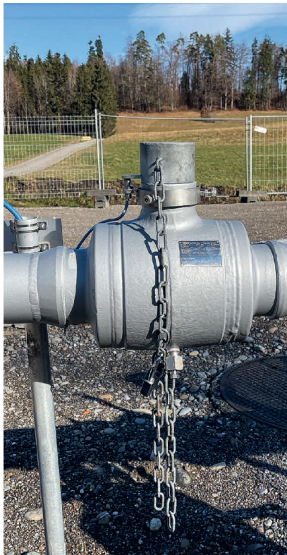
Vollverschweisster Kugelhahn aus Stahl, DN 100/114,3 mm ANSI 600, Dichtsystem PMSS, Sitzringsystem Double Piston mit Ent- leerungskugelhahn und Prüfstopfen.
