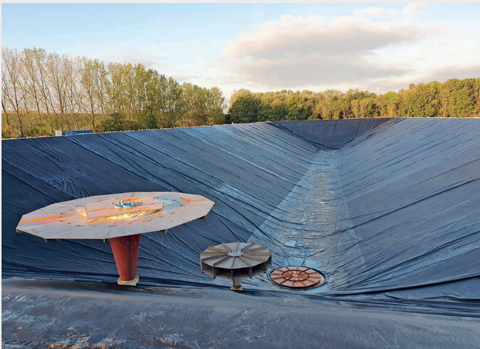
Fig. 6 Erdbeckenspeicher in Høje Taastrup, Dänemark [18].
