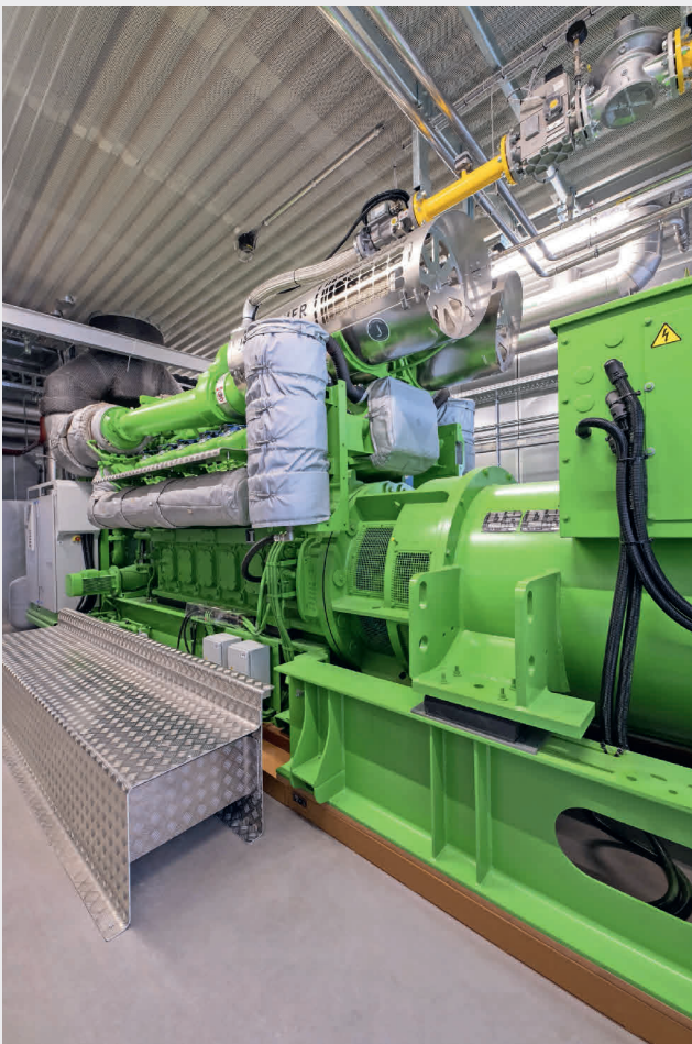
Fig. 6 Die Stadt St. Gallen setzt Erdgas befeuerte Blockheizkraftwerke ein, um Ölheizungen zu ersetzen und damit den Ausstoss von Treibhausgasen zu senken. Im Bild: eines der beiden Blockheizkraftwerke der neuen Fernwärmezentrale Lukasmühle mit 2 MW Leistung zur Wärme- und Stromproduktion.
