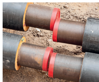
Der Fernwärme ist neben Gas und Wasser einer der drei Fachbereiche des SVGW. Das Regelwerk und die Ausbildungsangebote für den Fachbereich sind noch im Aufbau.
