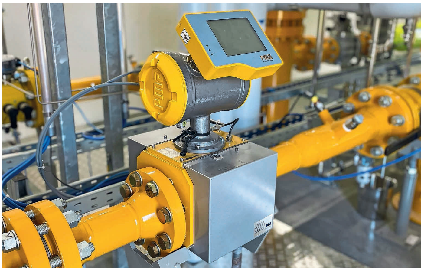
Der neue Ultraschallzähler misst in der neuen Druckreduzier- und Messstation Grüt zuverlässig und hochpräzise das Gasvolumen.
