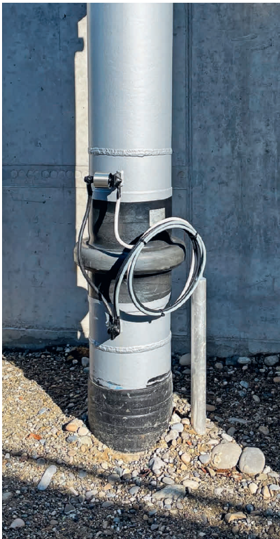
Isolierstück aus Stahl Typ ET, DN200/219, 1 mm PN16.
