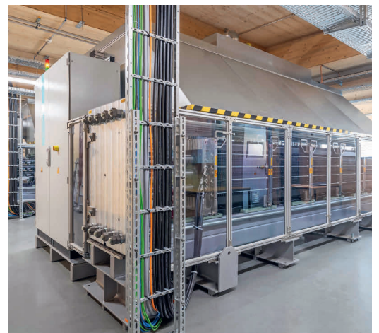
Elektrolyseur in der Power-to-Gas-Anlage von Limeco in Dietikon. (© Limeco)
